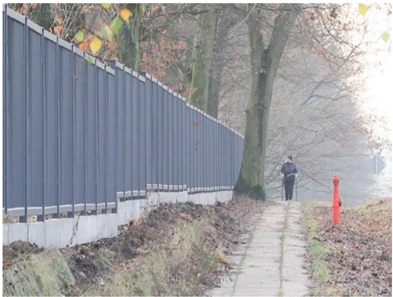
Nowe ogrodzenia szpitala w Krychnowicach to zwycięski projekt BOM
